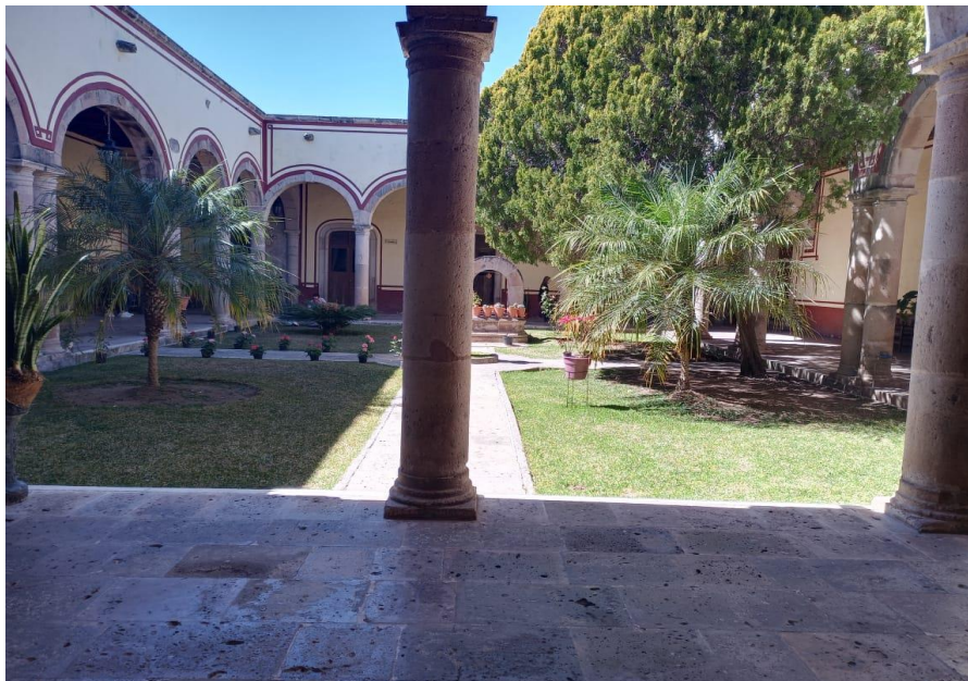
SE OBSERVA LA GRAN VENTILACIÓN QUE HAY PASILLOS ANCHOS
